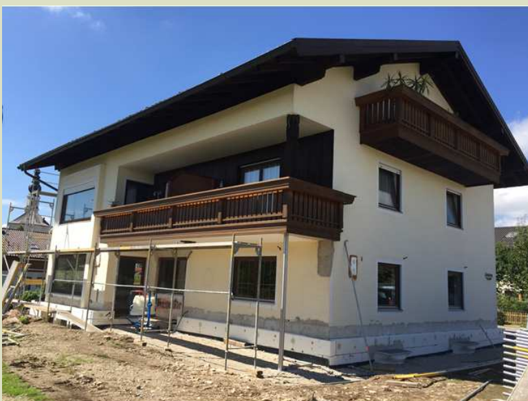
Altbausanierung Gius in 83374 Traunwalchen, Kreisstraße 3a
