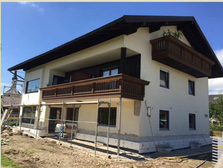
Altbausanierung Gius in 83374 Traunwalchen, Kreisstraße 3a
