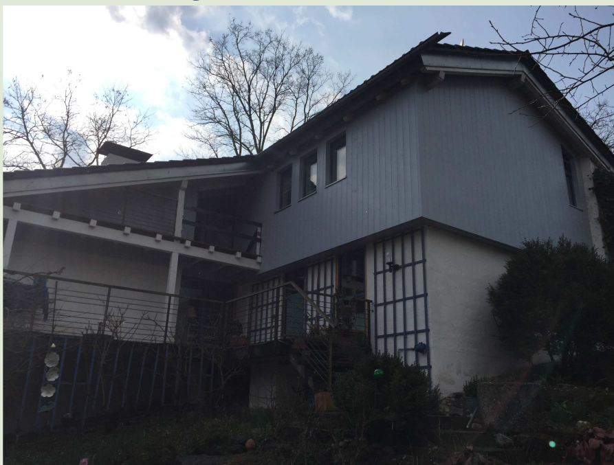
Sanierung eines EFH, Brunnhausstraße 8, 83083 Riedering
