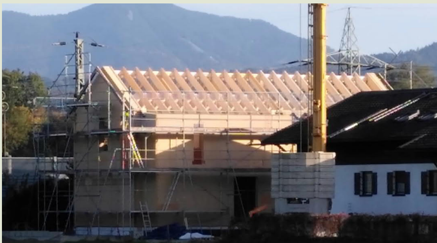
EFH Happung im Rohbau
