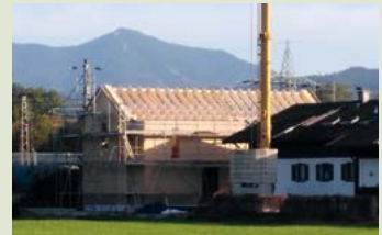
Holzbau im Rohbau
